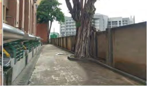
4. 工程館北側圍牆與人行空間 ( 西段 )
