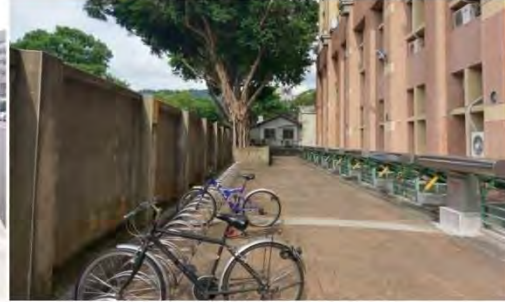
3. 工程館北側圍牆與人行空間 ( 東段 )
