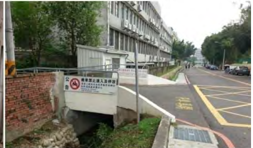
8. 機械工程館東側路口轉角視線阻隔不安全
