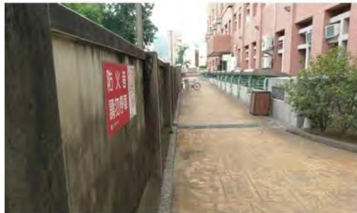
5. 管理館北側圍牆與通道
