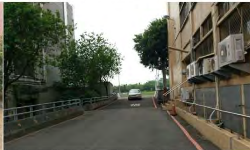
6. 機械工程館東側道路缺乏人行步道
